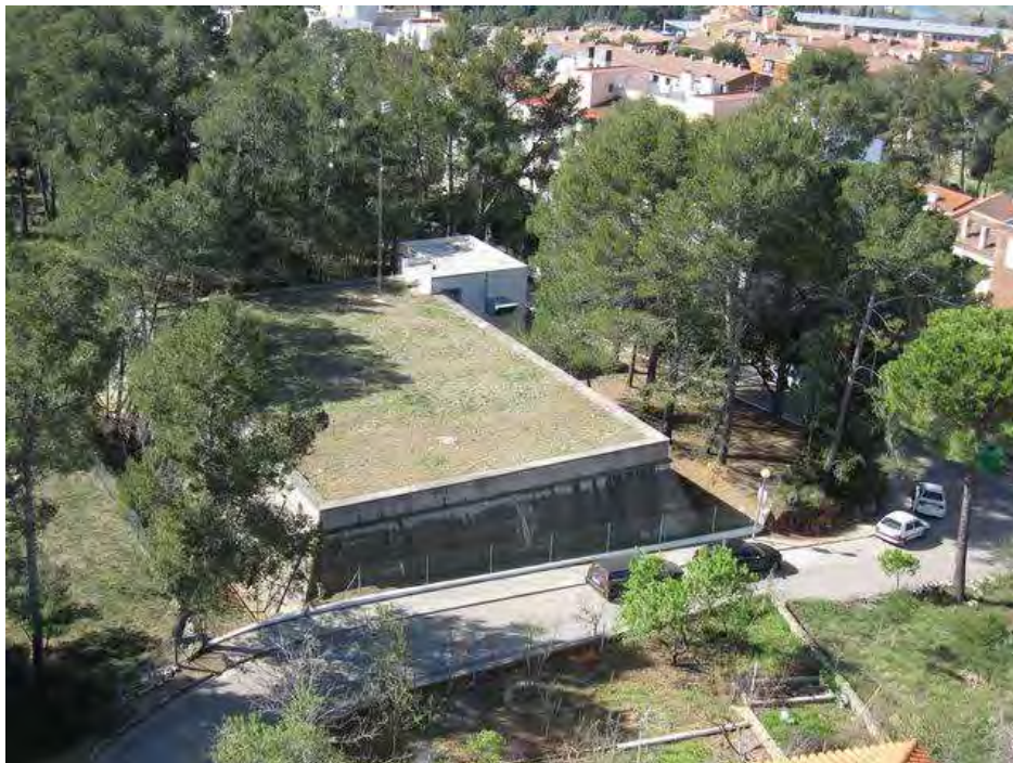
Central de Montjuïc
