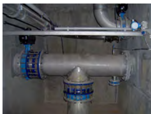
Sortida d'un filtre de Carbó Actiu
