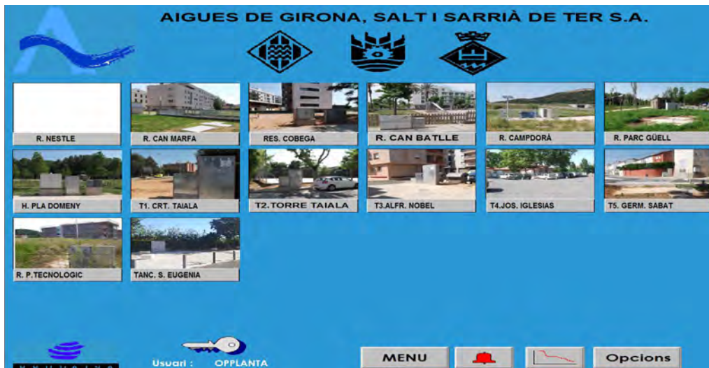
Imatge del telecontrol AGISSA
