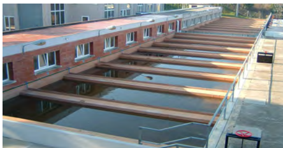
Vista dels filtres abans de cobrir-los
